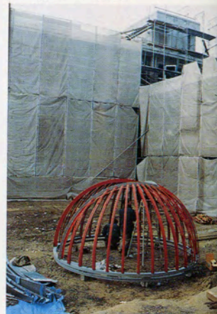
■ 天体ドーム建設
