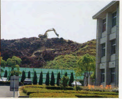
■校舎東側造成前
