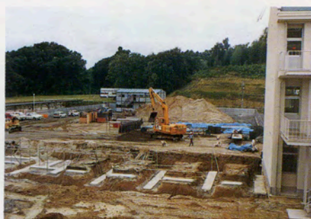
■ 第3期工事前のようなす
